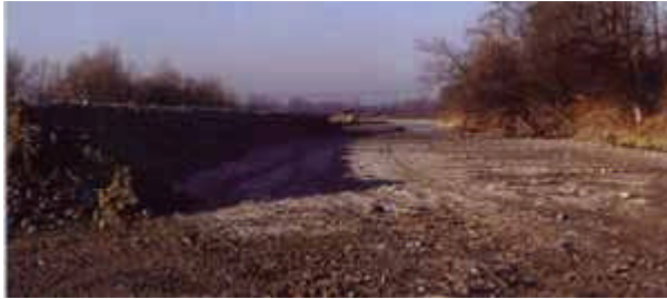
Escavazioni in alveo (foto Antonio Aiolfi)
