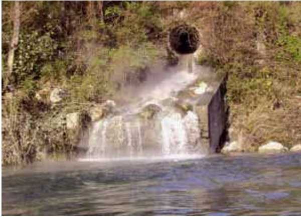
Immissione di acque provenienti da scarichi civili
